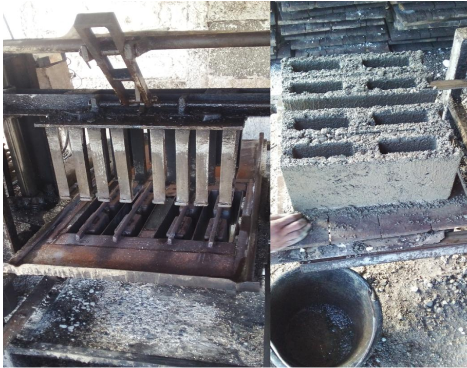
Figura 8: Preparación de los bloques en la maquina vibratoria.
