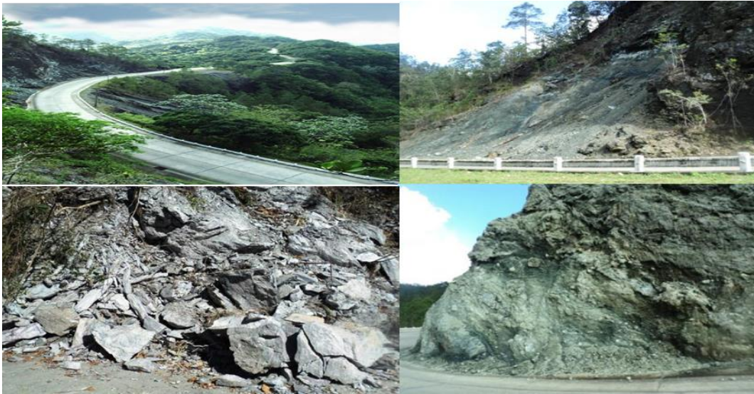
Figura 21. Deslizamiento del Viaducto La Farola.
