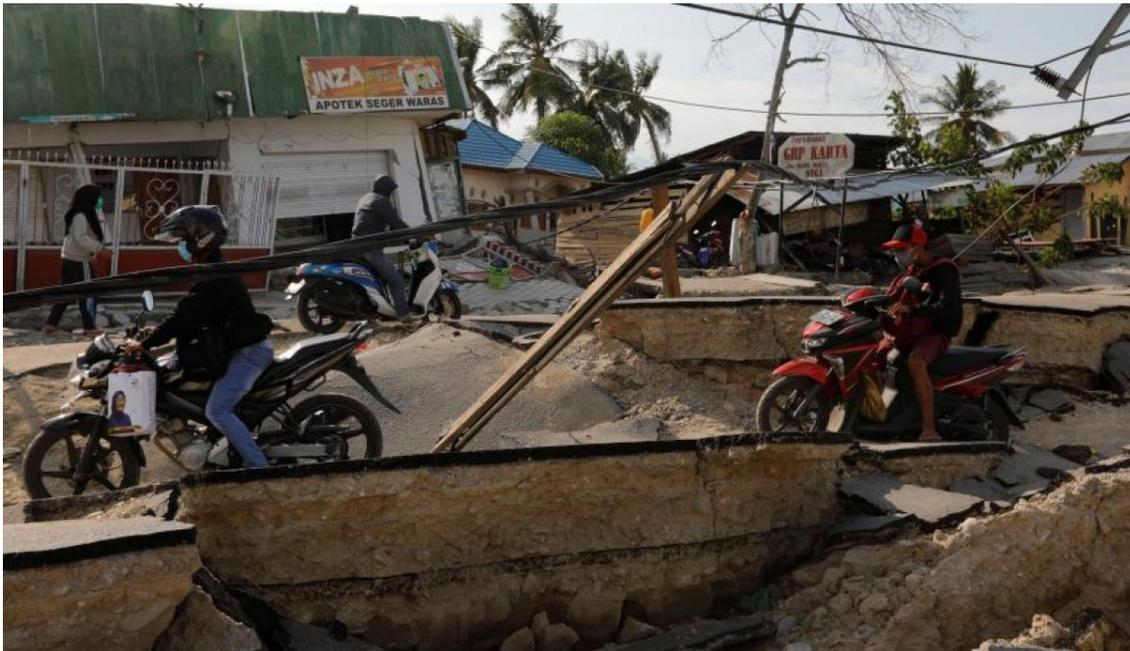
Figura 2: Licuefacción del suelo en Indonesia (Redacción EC, 2018).
