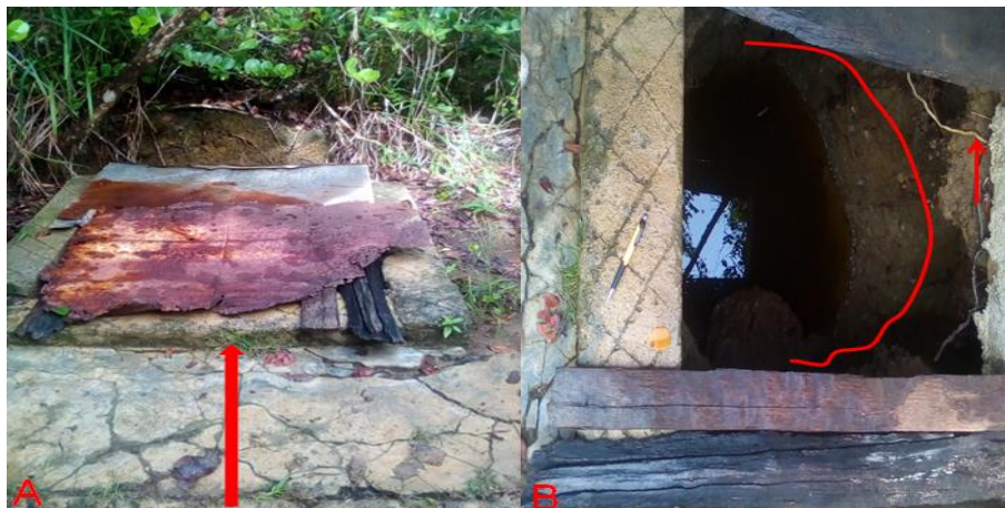
Figura 11. A: Pozo muestreado tapado, B: Presencia de sedimentos y raíces de arboles en las paredes del pozo.
