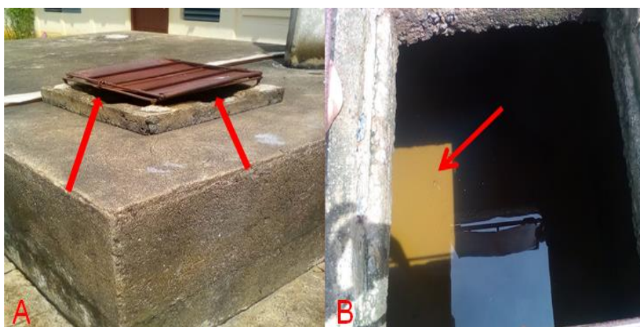
Figura 15. A: Cisterna muestreada, tapa no hermetica, B: Acumulacion de sedimentos en el interior de la cisterna.
