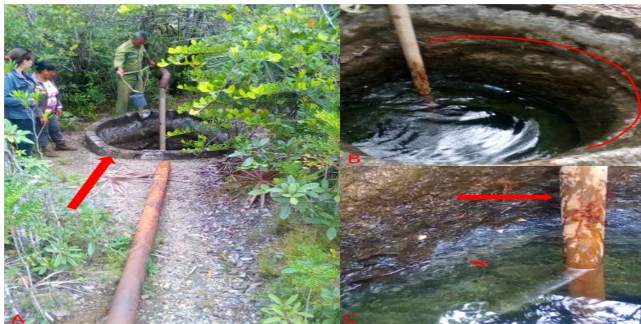
Figura 19. A: Pozo destapado, B: Las paredes del pozo se encuentran reforzadas con cemento, C: Tubería de metal introducida en el agua, la misma se encuentra oxidada.
