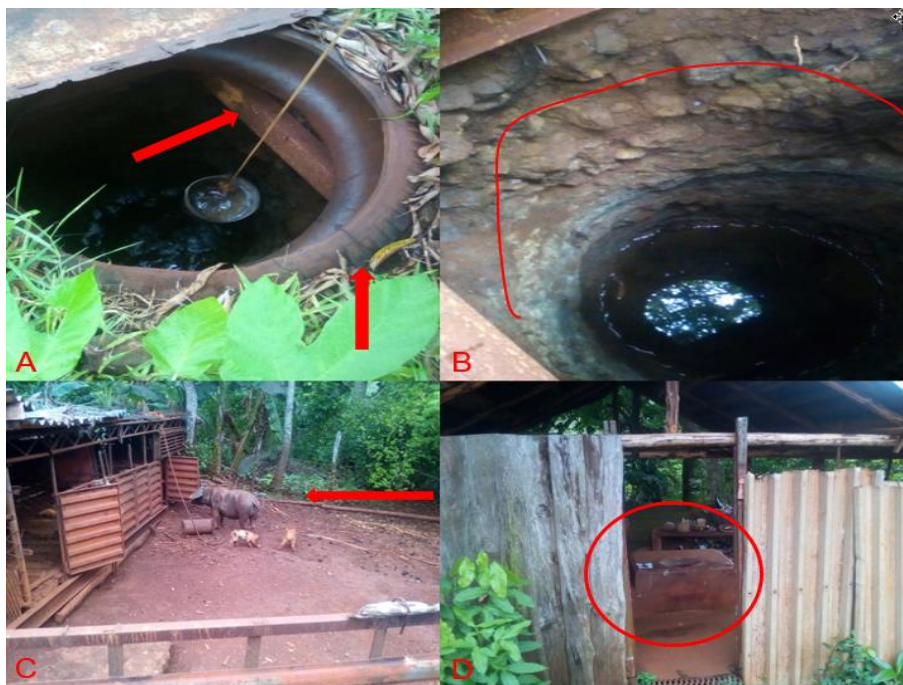
Figura 20. A: Pozo criollo donde se observa en su superficie un neumático y en sus paredes vigas metálicas con presencia de óxido, B: Paredes del pozo sin protección, C: Corrales de cerdos cercanos del pozo, D: Presencia de una letrina cerca del pozo.
