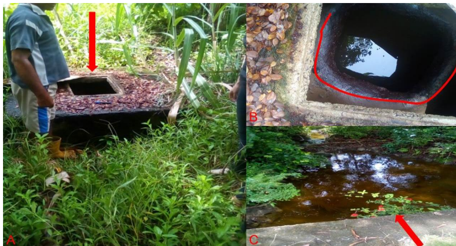
Figura 14. A: Pozo muestreado, B: Paredes del pozo reforzadas con cemento, C: Arroyo cercano al pozo.
