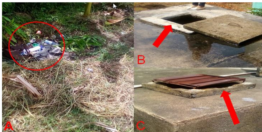
Figura 21. A: Vertido de desechos sólidos cerca de la cisterna del CMF de Cañete. B y C: Cisternas destapadas de los consultorios médicos de Cañete y Cupey respectivamente
