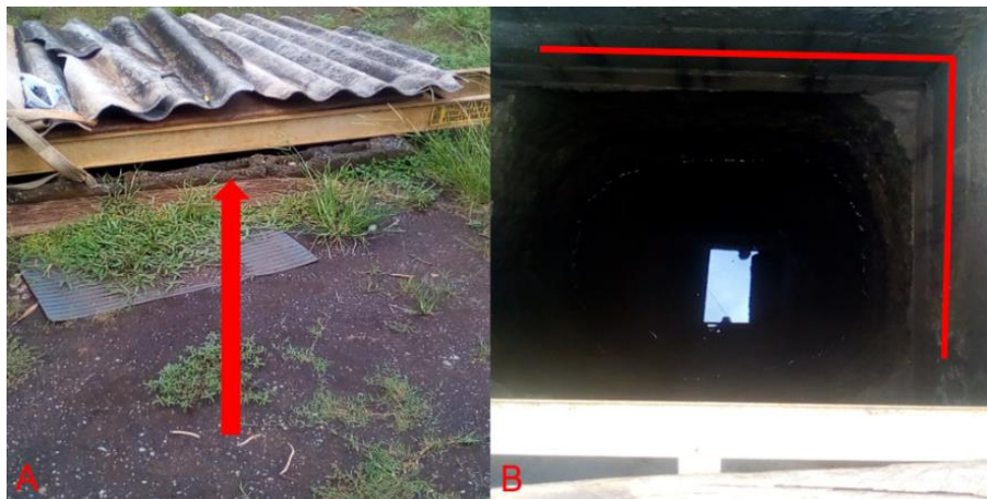
Figura 18. A: Pozo muestreado, se encuentra tapado pero la tapa no es hermética, B: Las paredes del pozo reforzadas con cemento.
