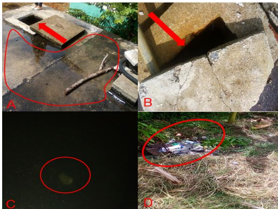
Figura 12. A: Vista superior de la cisterna de Cañete, destapada y con acumulación de agua en su superficie, B: Punto por el que entra el agua a la cisterna, no hermético, C: Presencia de objetos en el interior de la cisterna, D: Micro vertedero cercano a la cisterna.
