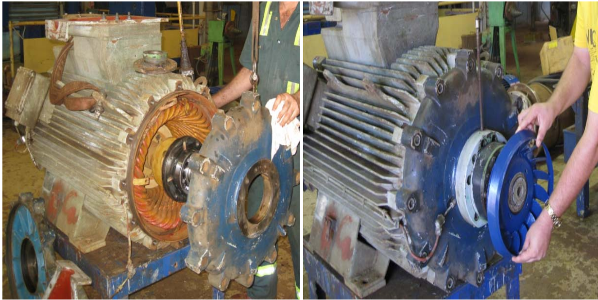
Figura 2.1f Motor eléctrico de 200 kW
