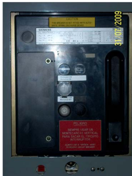
Figura 2.1d Interruptor Siemens de 2000 A
