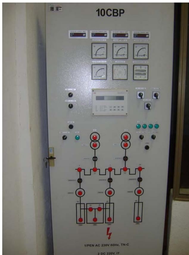
**Figura 2.13 Panel de sincronización central.**
