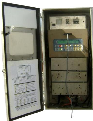
**Fig. 2.1** Dispositivo de protección y Medición (NU-Lec).
