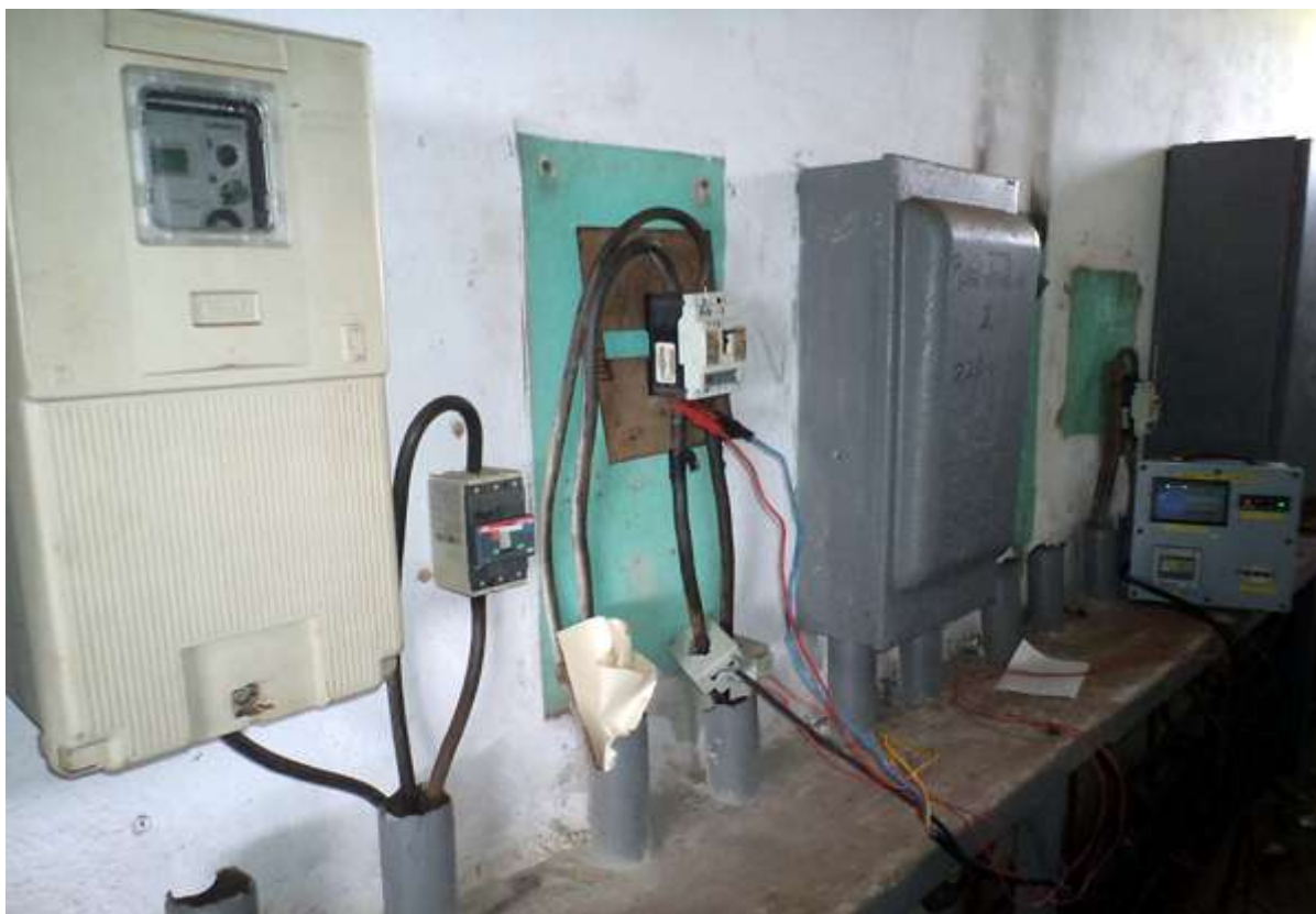
UPM conectada al breaker de la residencia #3 del ISMM.
