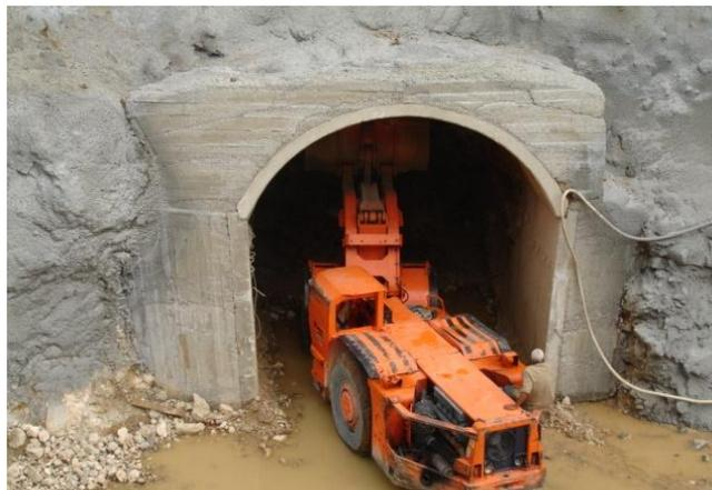
Figura 3.2 Emboquille mediante la fundición con pre fabricado en el túnel conexión I, Traslase Este – oeste
