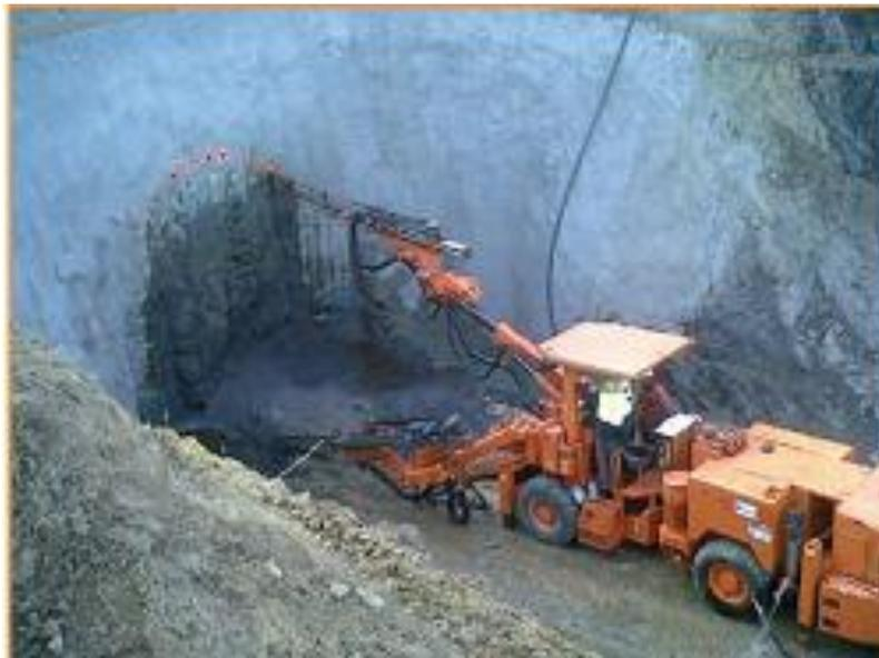
Anexo 8. Replanteo de los topográficos para la colocación del Paraguas
