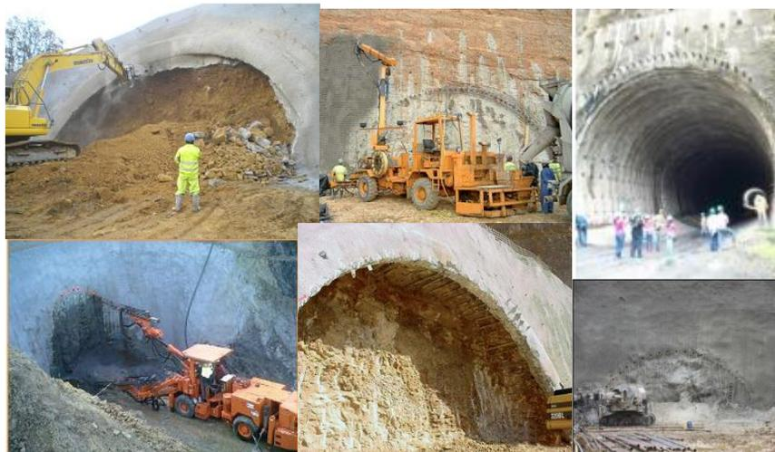
Figura 1.3 Emboquille de túneles con paraguas de micropilotes
