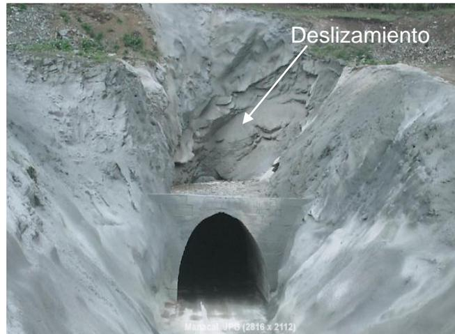
Figura 3.4 Deslizamiento del talud frontal en el emboquille del túnel Manacal – Castellano del Traslase Este - Oeste
