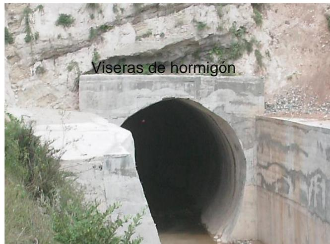
Ver figura 3.3 Emboquille con viseras de hormigón
