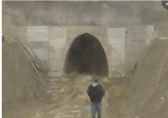
Figura 3.1 Emboquille mediante la fundición de hormigón In Situ en el túnel Buenaventura del Traslase Este – Oeste
