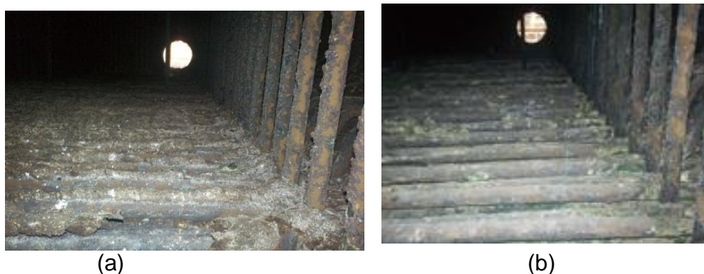
Figura 3.2 Calderas después de la prueba (a) y limpieza (b) con el aditivo PENTOMAG 4100.
