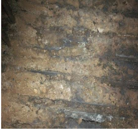
Figura 3.7 Caldera después de la limpieza
