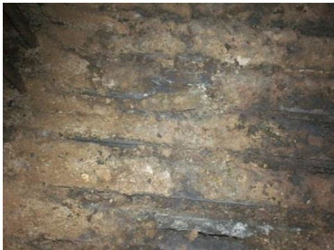
Figura 3.13 Caldera después de la limpieza
