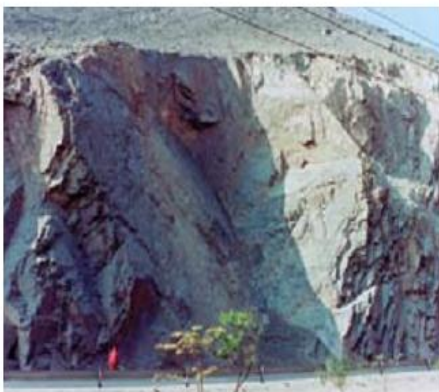
Figura 3.2 Deslizamientos por la estratificación.
