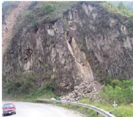
Figura 3.2 Deslizamientos por la estratificación.
