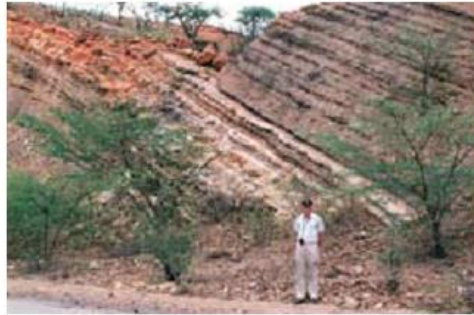
Figura 3.2 Deslizamientos por la estratificación.
