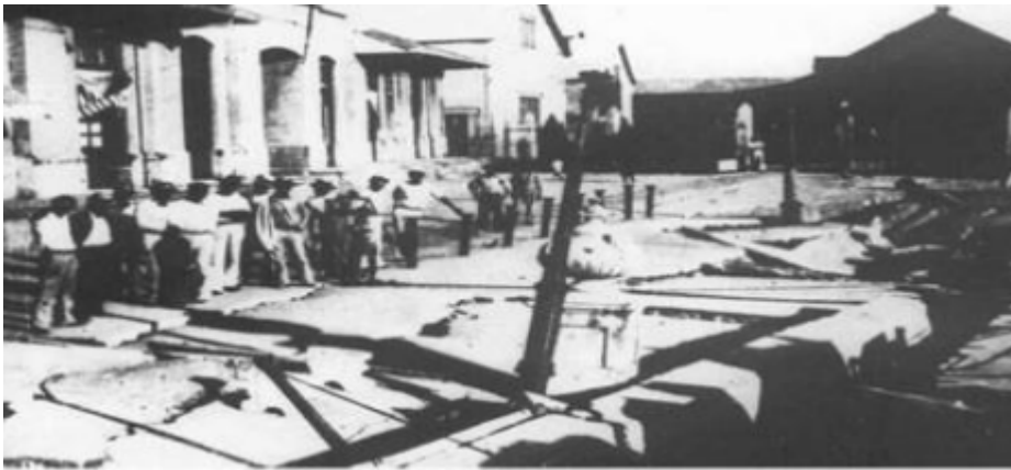
Figura 3. Licuefacción de los suelos en calle La Alameda, en Santiago de Cuba. Terremoto del 3 de febrero de 1932. Tomado de Chuy (2002).
