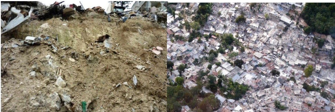
Figura 2. Izquierda. Perfil de los suelos arenosos arcillosos del valle de la Ciudad de Puerto Príncipe, generador de altas intensidades durante el proceso sísmico. Estos suelos son muy licuables. Derecha. Se muestra una vista aérea, en planta del terreno, donde todas las viviendas sufrieron grandes daños provocados por su asentamiento en suelos licuables de la ciudad.
