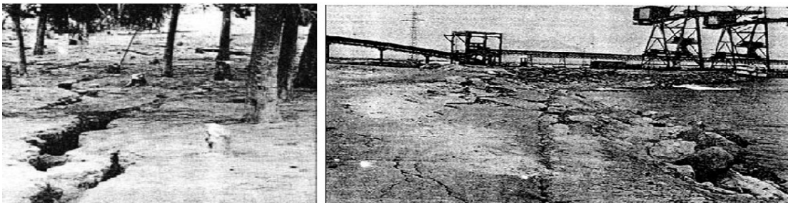
Figura 1. Izquierda: Agrietamiento del terreno en la llanura aluvial del Río Lacramarca. Derecha: Daño en el Puerto de Chimbote. Derrumbe del camino pavimentado. Una y otra imagen se tomó luego del terremoto en Chimbote, Perú (1970).
