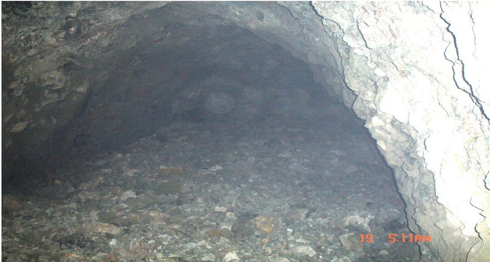
Figura 32 Registro fotográfico del contorneado obtenido con voladuras experimentales en brechas de gabro. Frente:Ojo de Agua-Serones.Túnel Yagrimal-Guaro.
