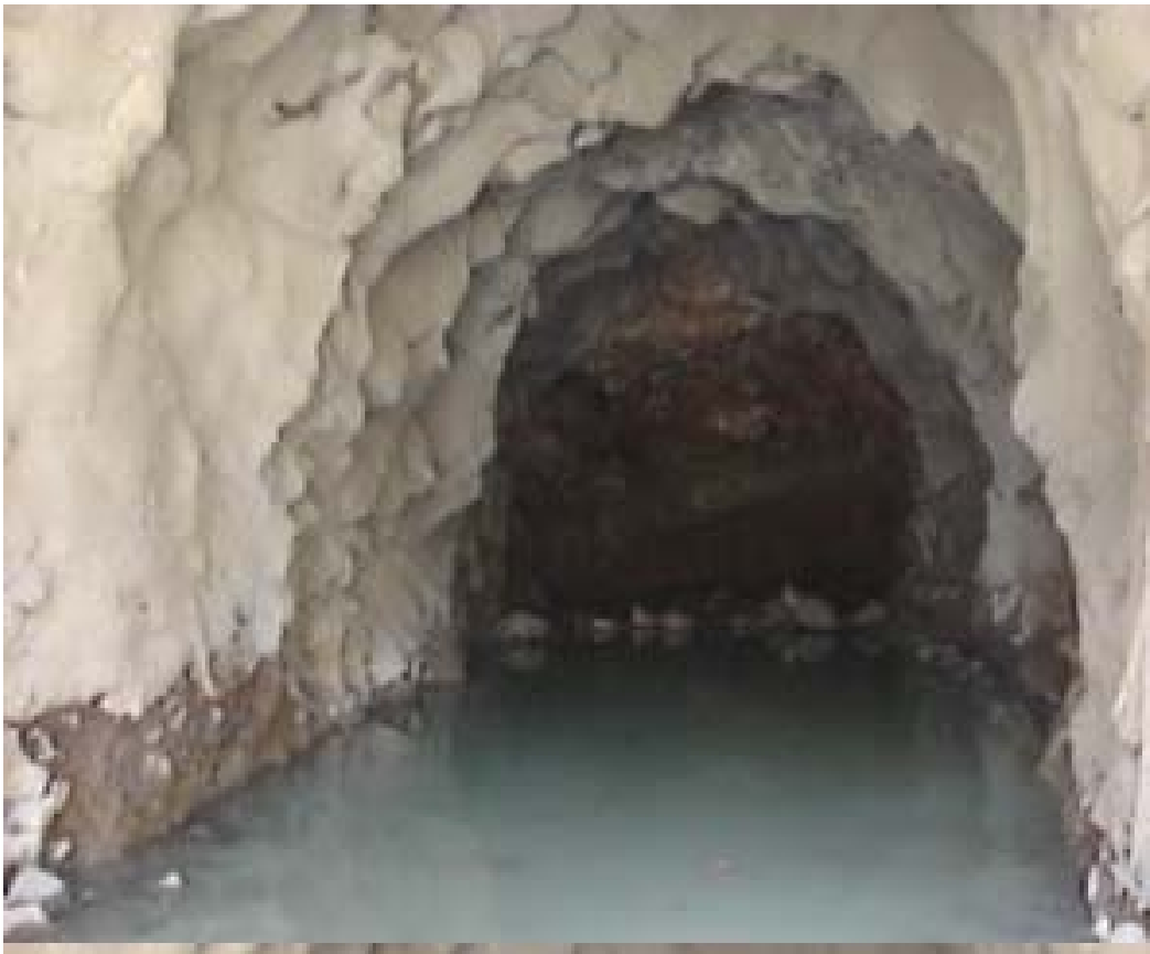
Figura 2. Registro fotográfico del contorneado del túnel obtenido por voladuras experimentales en el emboquille Serones-Guaro.
