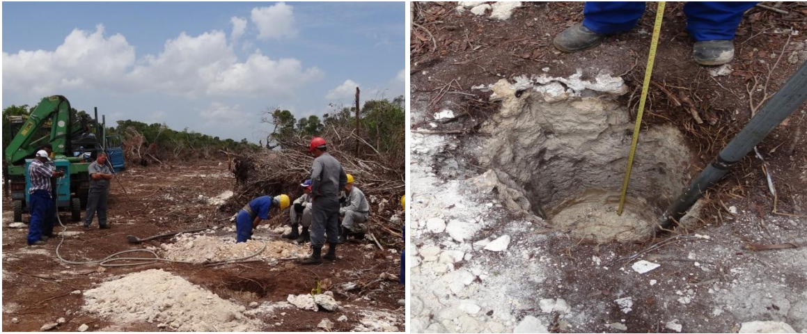
Figura 19. (Fotos) A la izquierda trabajos de excavación. A la derecha excavación (0.80 m de diámetro y 1.40 m de profundidad).
