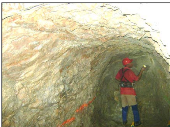
Fig. No. 40. Ubicación de barrenos para colocación de explosivos en la galería.
