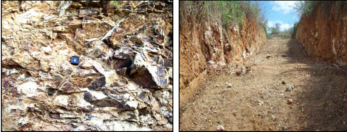
Figs. No. 15 y 16. Imágenes de trincheras donde pueden apreciarse diferentes familias de grietas.
