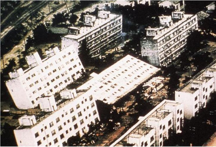
Figura 1 Foto: Efectos de licuefacción de los suelos durante el terremoto en Nigata, Japón, 1964. Environmental Geology, Montgomery, Carla. 2002
