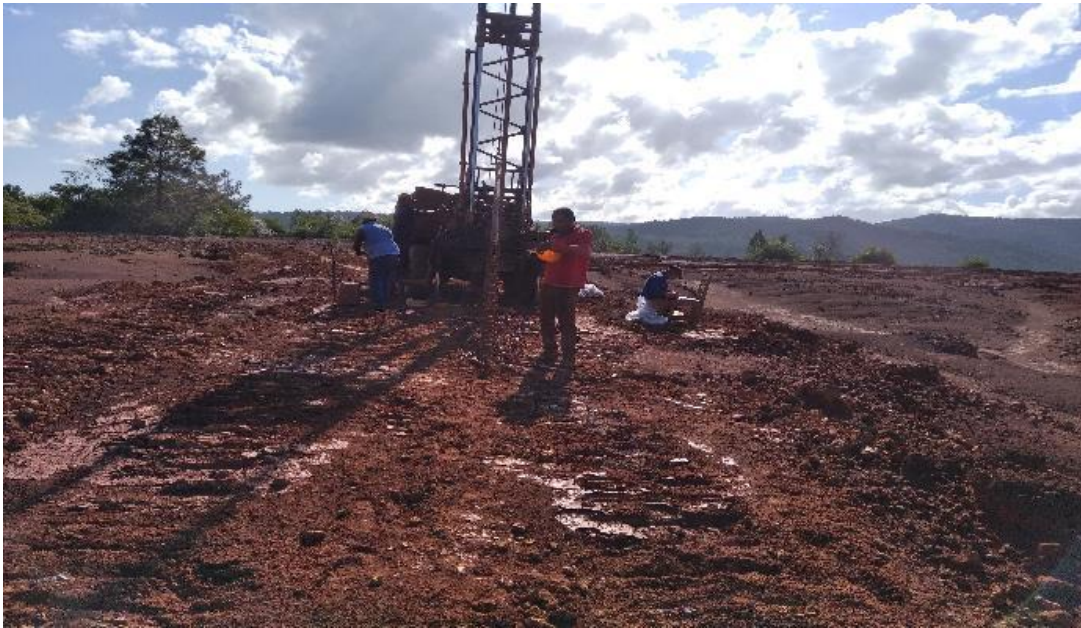
Figura 2.1. Pozos de perforación en la etapa de exploración geológica
