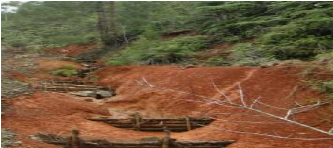
Figura 6. Cárcava con su respectiva corrección
