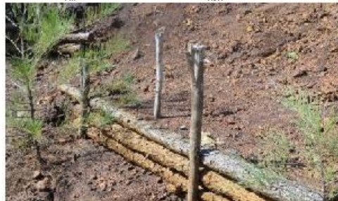
PROTECCIÓN CONTRA LA EROSIÓN CON MADERA
