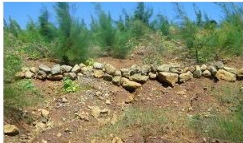
PROTECCIÓN CONTRA LA EROSIÓN CON ROCAS
