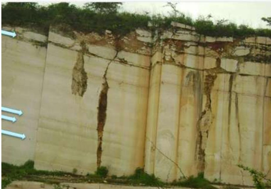
Figura 3. Grietas de estratificación.
