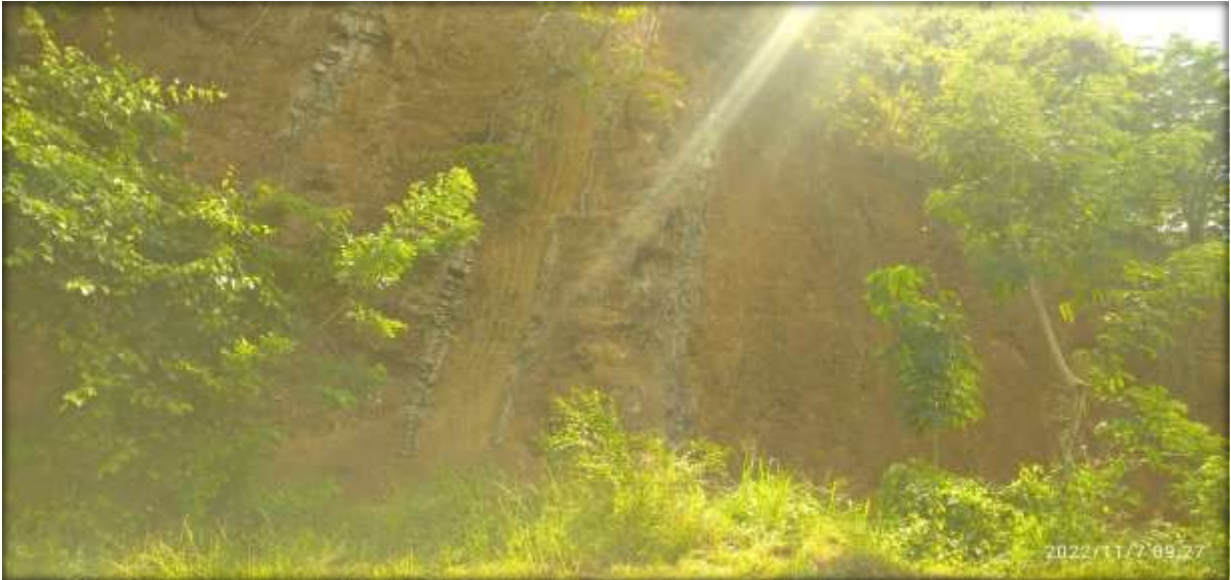
Figura 26. Talud d 50 metros de altura.
