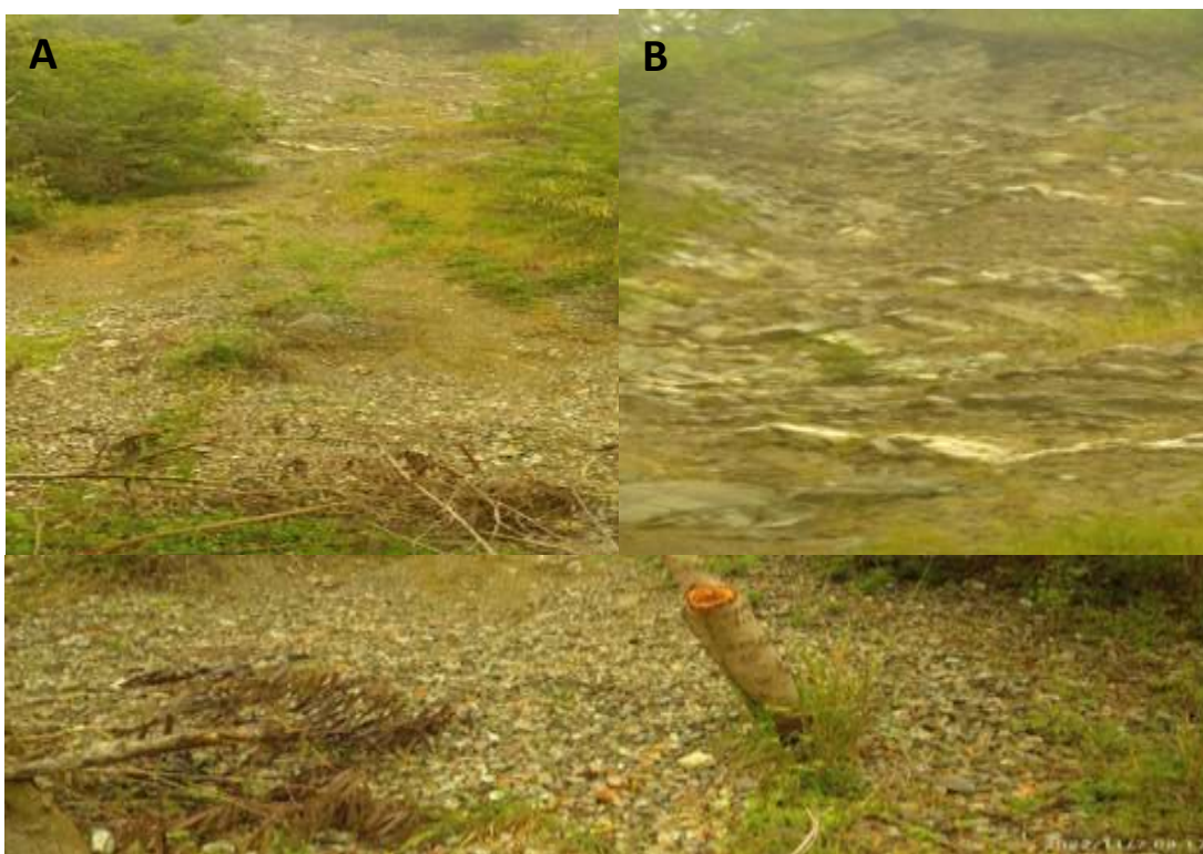
Figura 23. A) y B) Talud de 150m de altura. Material acumulado.
