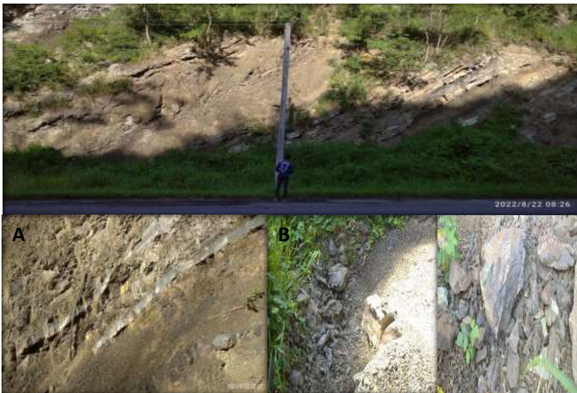
Figura 15. Tobas estratificadas e intemperadas. A) Y B) Desprendimientos de material rocoso.
