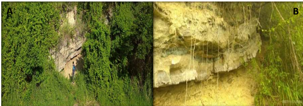
Figura 17. A) Talud cubierto de vegetación B) Tobas con buzamiento de 30 grados.
