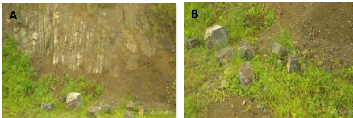
Figura 25. A) Talud de 30 metros de altura y B) Material desprendido.
