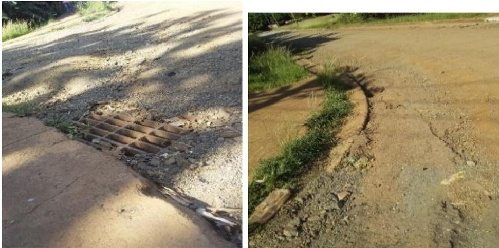
Figura 20: Afectación sistemática de alcantarillado, reparto Miraflores.
