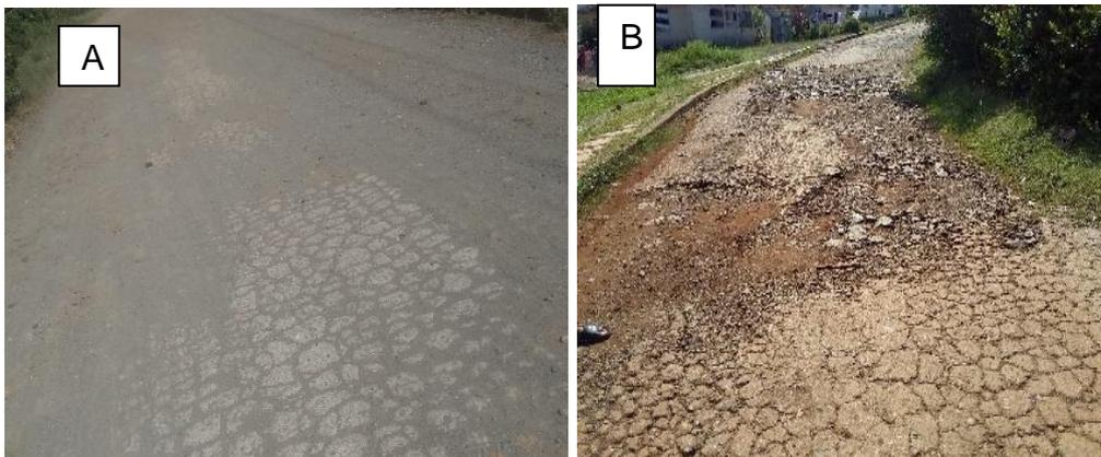
Figura23: Piel de cocodrilo con A- severidad baja en Viviendas Checas y B- con severidad alta en Miraflores.
