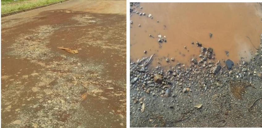
Figura 24: Hundimiento del vial con severidad alta e influenciado por la erosión en el reparto Miraflores
