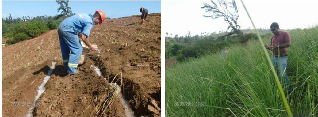
**Figura 28:** Aplicación de hidrogel y pastos en el talud oeste de la presa de colas, antes y posterior a la implementación.
