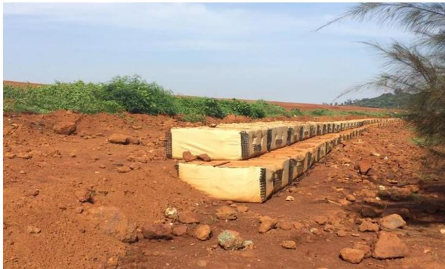
**Figura 20:** Implementación de hydroblock en el dique de la extensión norte de la presa de colas.
