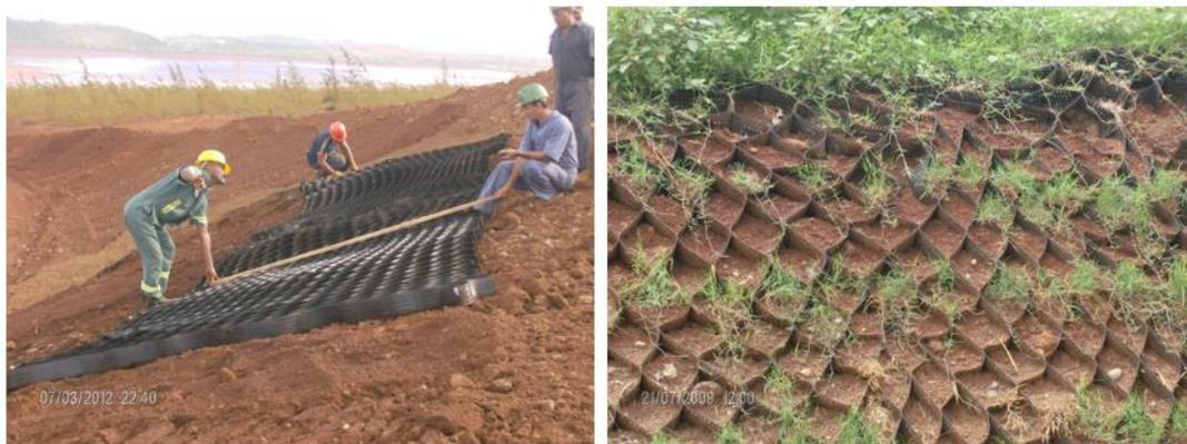
**Figura 18:** Instalación de geomallas en los taludes de la presa.
