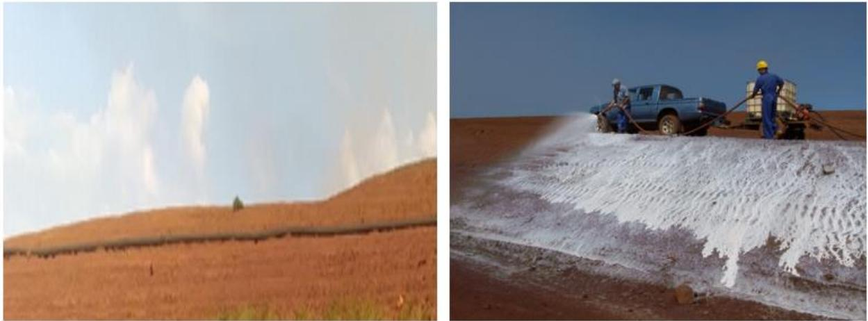
**Figura 29:** Aplicación de polímeros para la estabilidad de los taludes de la presa de colas.
