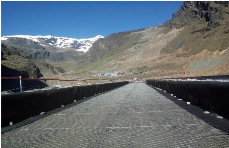
**Anexo B:** Tendido de gaviones y geotextiles para relleno de material de préstamo.
