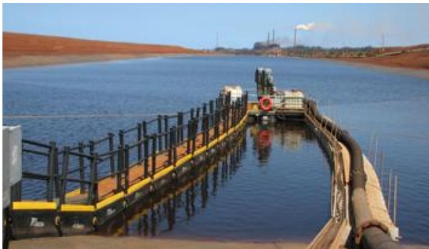
**Figura 21:** Sistema de bombeo para la recirculación de las aguas de la presa de colas.
