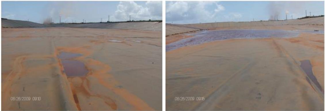
**Figura 19:** Impermeabilización de los sedimentadores con geomembranas.
