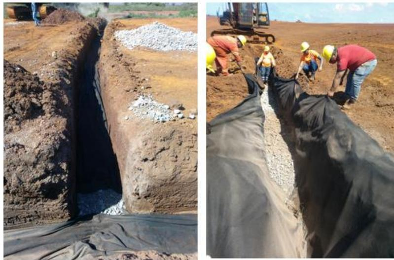
**Figura 25:** Construcción de un dren francés en la Extensión Norte para la disminución del nivel freático.
