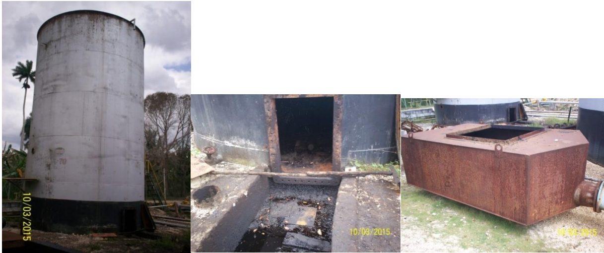
Figura 6. Tanque 70 del Centro Colector Jatibonico, sometido a limpieza para su reparación.
