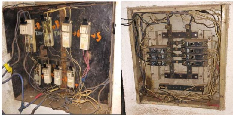
**Figura 2.7.** Estado físico del sistema de suministro eléctrico del círculo
