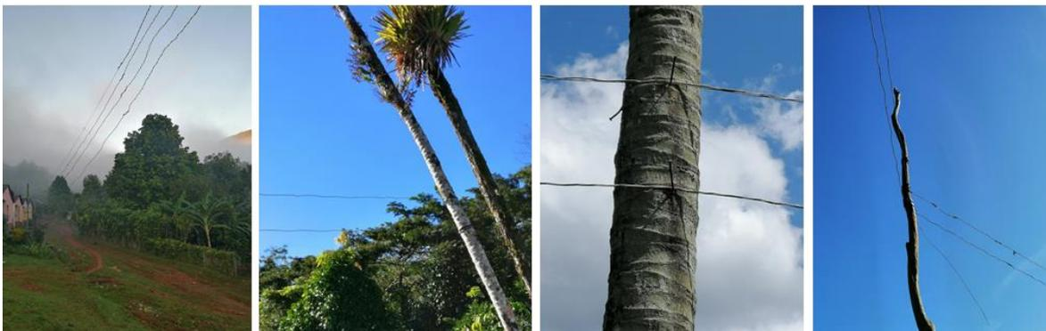
**Figura 3.5.** Estado de las redes de suministro y formas de emplazamiento en el terreno
