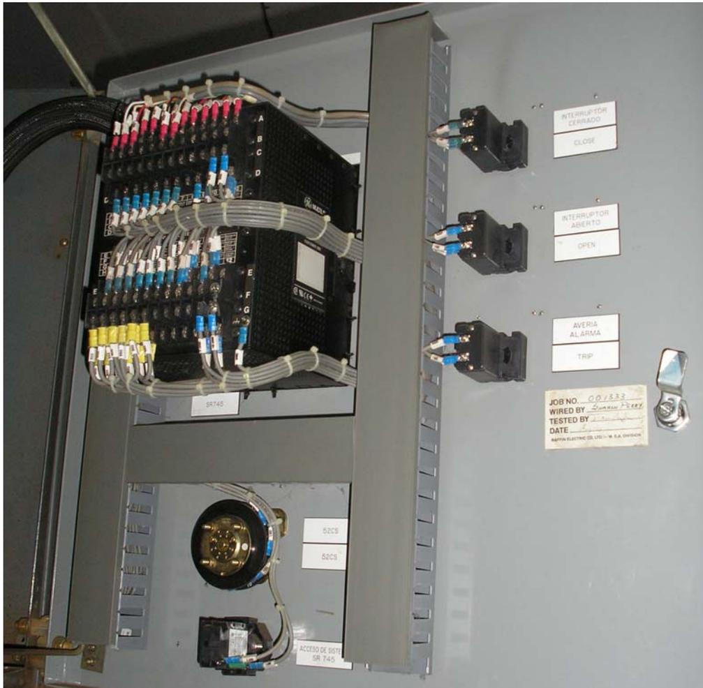
**Figura 1.3.** Vista interna de un gabinete modernizado.
