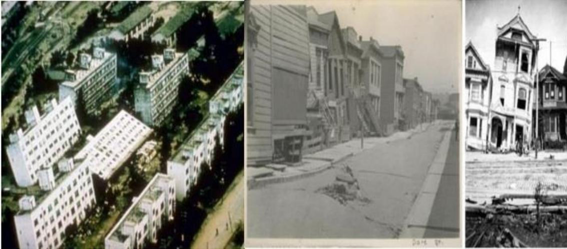
*Imagen 1: Izquierda: Efecto de la licuefacción en edificios post terremoto de Niigata 1964. Derecha: Cráteres de arena en el área de Milpitas luego del terremoto de San Francisco en 1906.*
