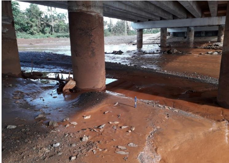
Figura 43. Acumulación de sedimentos del pilar 8 luego de intensas lluvias.
