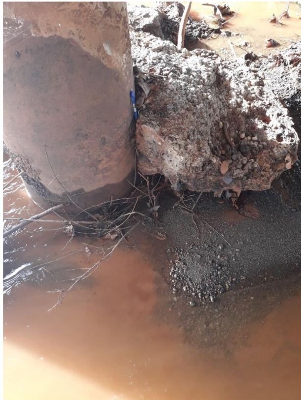
Figura 32. Acumulación de sedimentos en el pilar 4.
