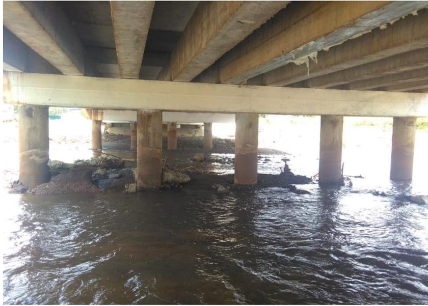
Figura 34. Vista lateral de los pilares con el cauce del río Cabaña estable.
