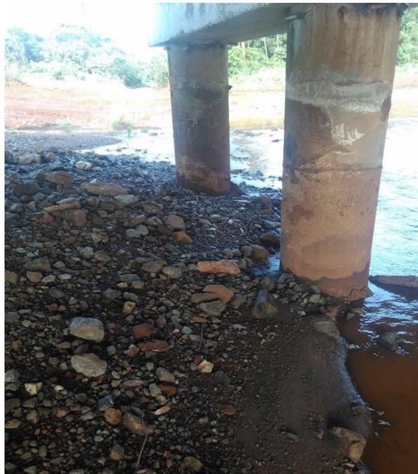
Figura 38. Acumulación de sedimentos en los pilares 6 y 7.
