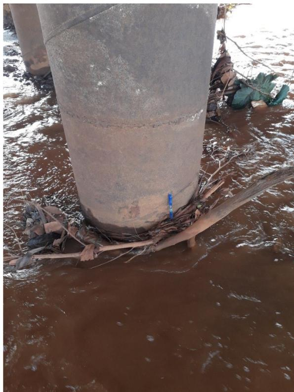
Figura 30. Presencia de ramas en el pilar 2.
