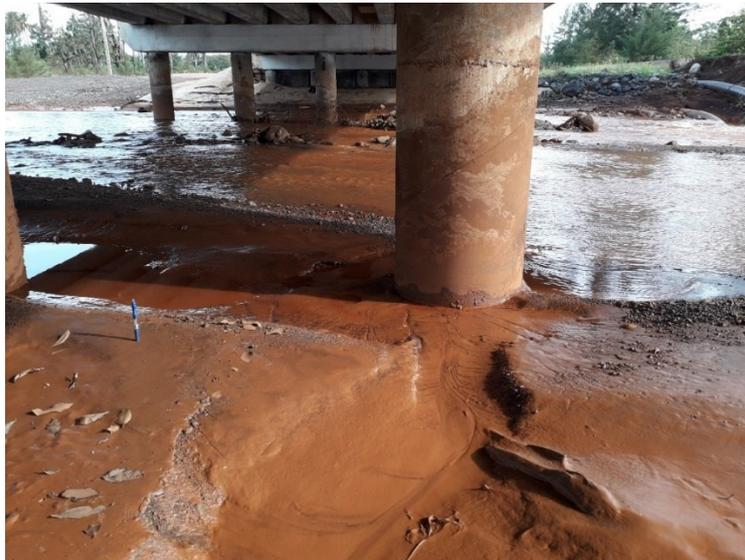
Figura 44. La acumulación de sedimentos en el pilar 9 luego de una crecida.
