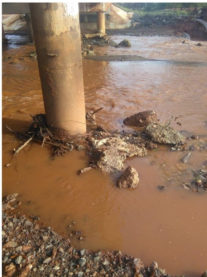
Figura 47. Pilar 10 en una crecida del río Cabaña.
