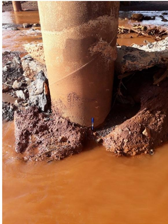
Figura 35. Acumulación de los sedimentos consolidados en el pilar 5.
