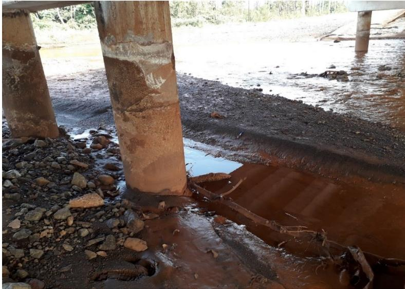
Figura 41. Acumulación de sedimentos en el pilar 7.
