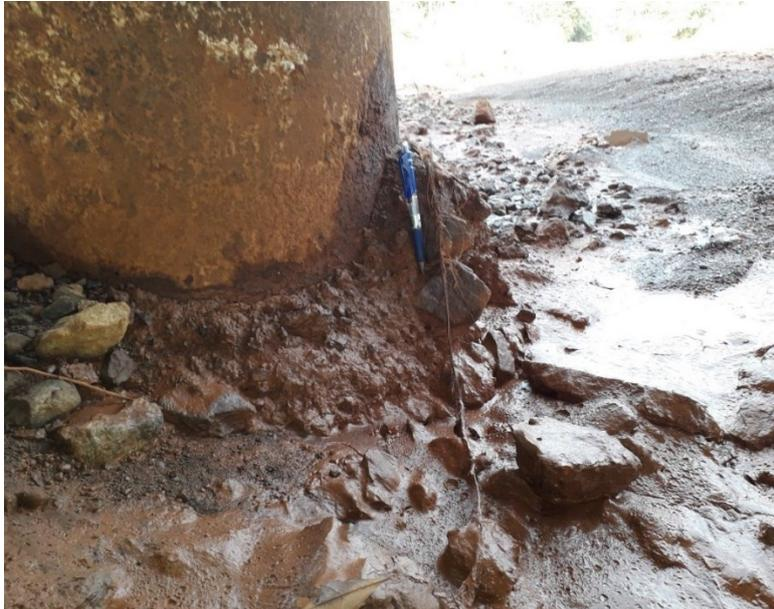
Figura 37. Acumulación de sedimentos consolidados del pilar 6.
