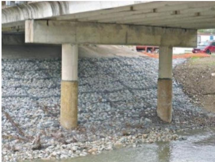
Figura 48. Protección de pilares con (pantallas).
