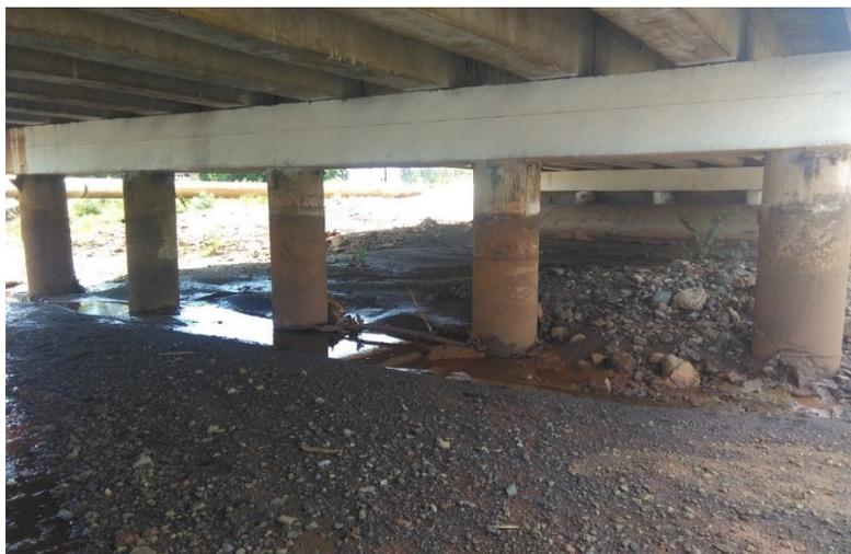
Figura 40. Acumulación de sedimentos cuando no existen precipitaciones.
