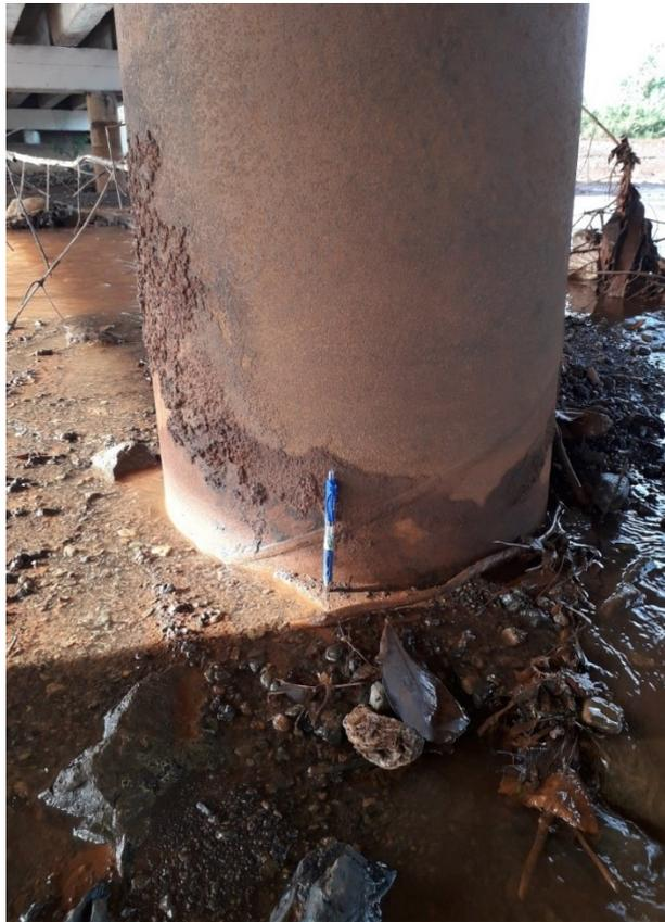
Figura 31. Acumulación de sedimentos en el pilar 3.
