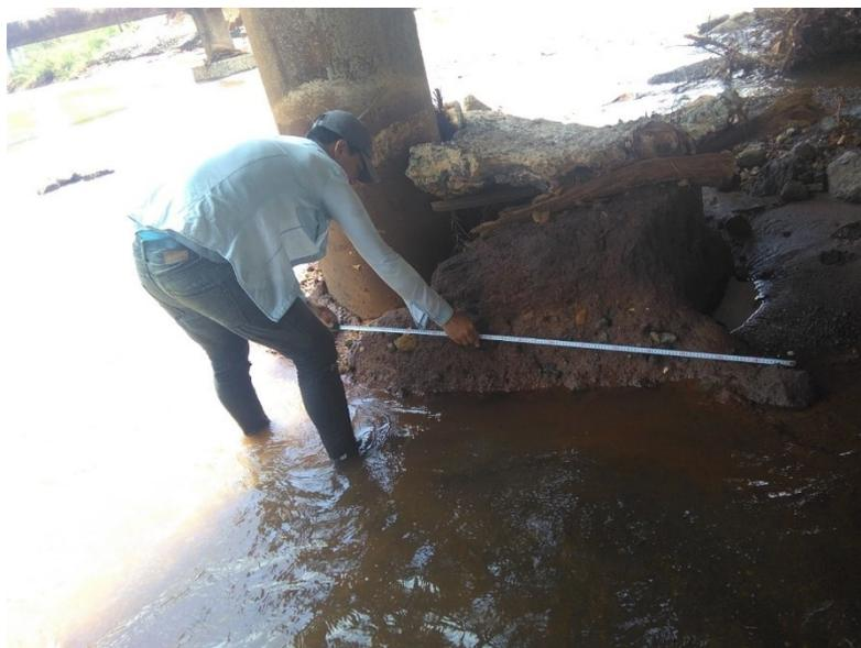
Figura 36. Medición de la acumulación de sedimentos consolidados en el pilar 5.
