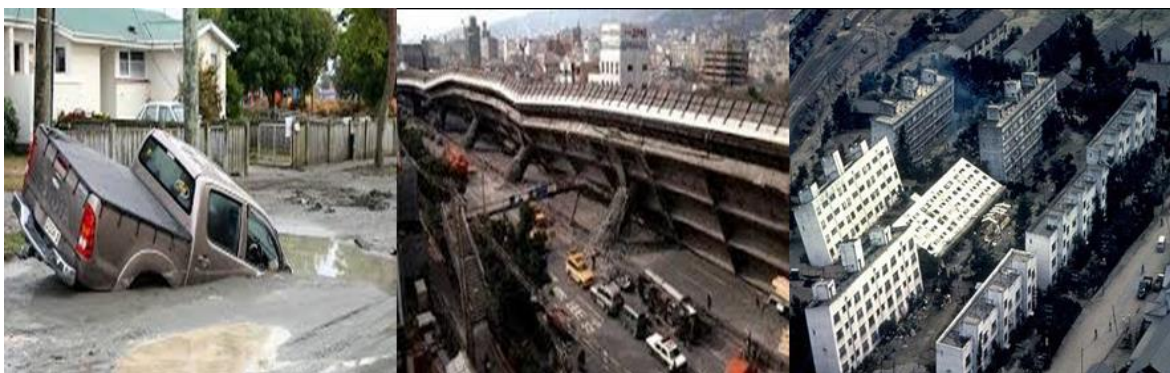
Figura 1. Efectos de la licuefacción de los suelos para el hombre. ( https://concienciaradio.com/liquefaccion/ )
