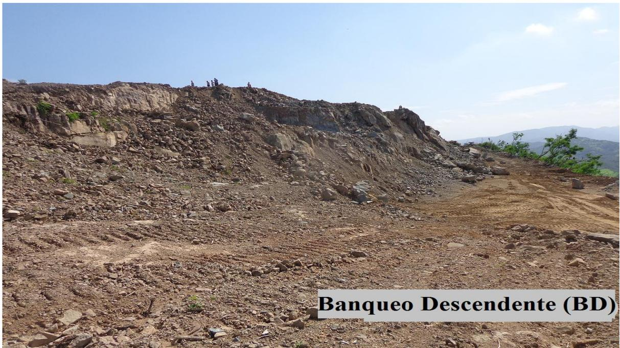
Figura 3-1. Método de explotación por banqueo descendente (BD)
