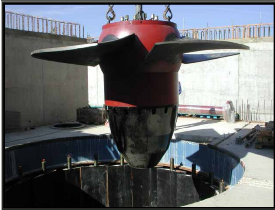
Foto 3. Turbinas Kaplan y de hélice.
