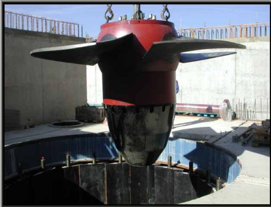
Foto 3. Turbinas Kaplan y de hélice.
