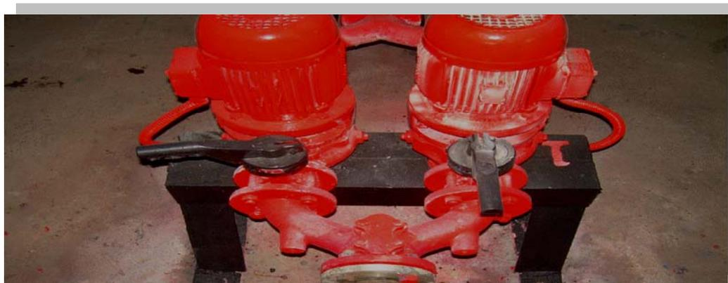
**Figura 3.21. Ejemplo de las bombas centrífugas instaladas en los CPAC, CSAC Y CR**
