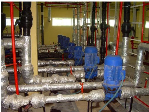
**Figura3.2. Bombas del Circuito Secundario de Agua Fría**
