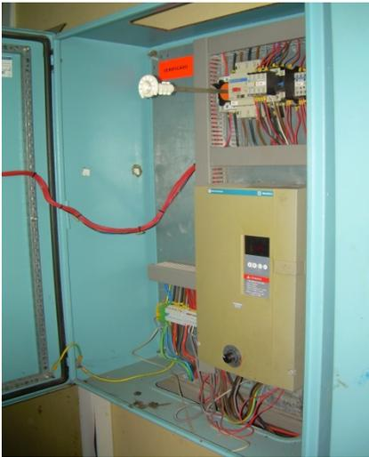
**Figura. 3.3 Variador de velocidad (V.V.)**
