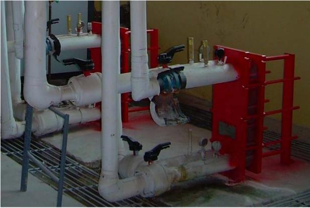
**Figura 3.20. Intercambiadores de calor a placas del sistema**
