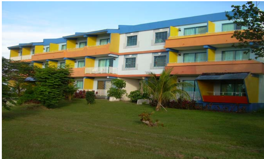
Fig. 2.1 Edificio del cual se tomó los resultados de la simulación térmica.
