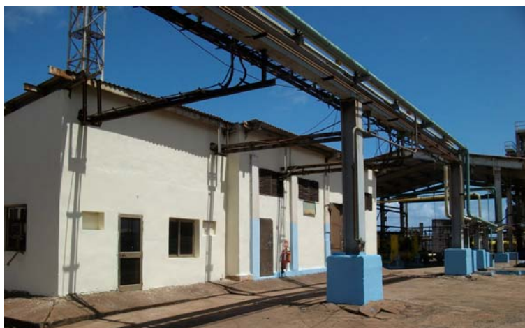
Figura 2.1a Lugar donde se encuentra la subestación de amoníaco de la Empresa Puerto Moa
