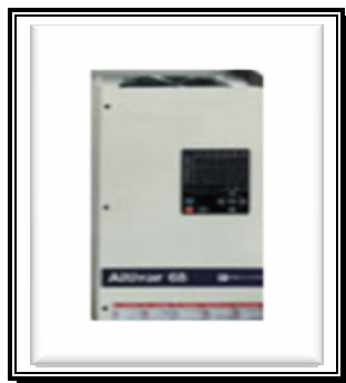
Figura 1.4: Variador de velocidad Altivar 68 ubicado en la Planta de Lixiviación y Lavado de la empresa Cmdte. Ernesto Che Guevara, Moa, Holguín.
