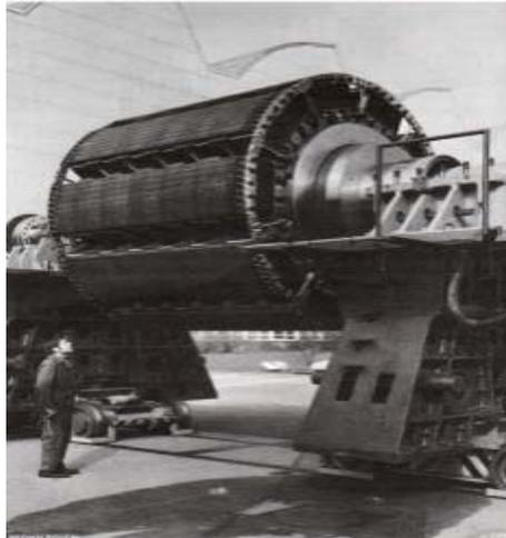
Figura 1.3. Rotor de polos salientes de una máquina sincrónica de 13,8 [kV], 152,5[MVA].
