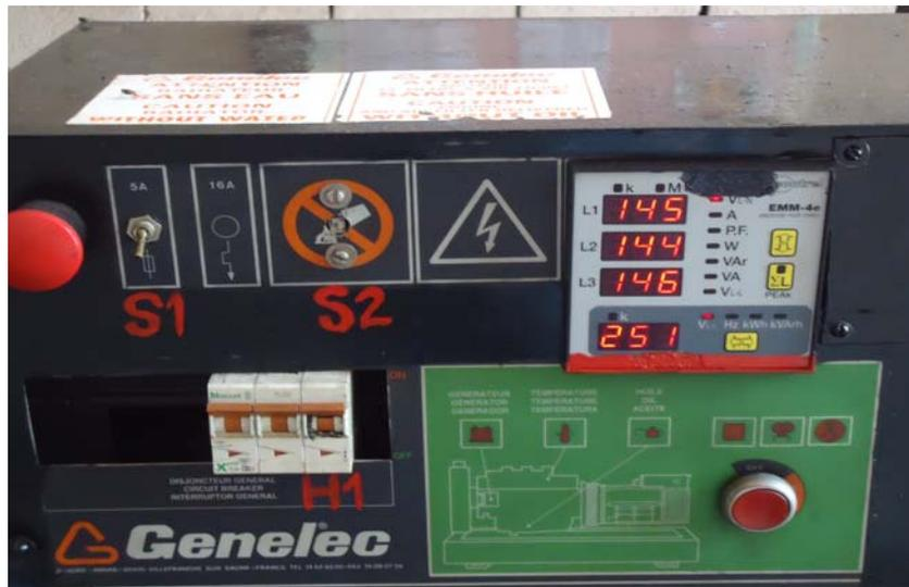
Fotografía de la pizarra de control del generador auxiliaren funcionamiento del ISMM.
