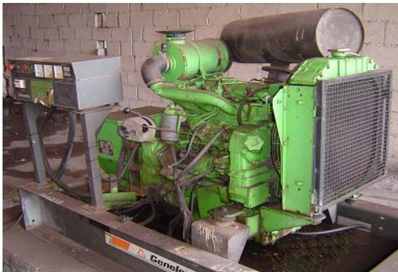
Fotografía que muestra el generador auxiliar del ISMM antes de la reparación.
