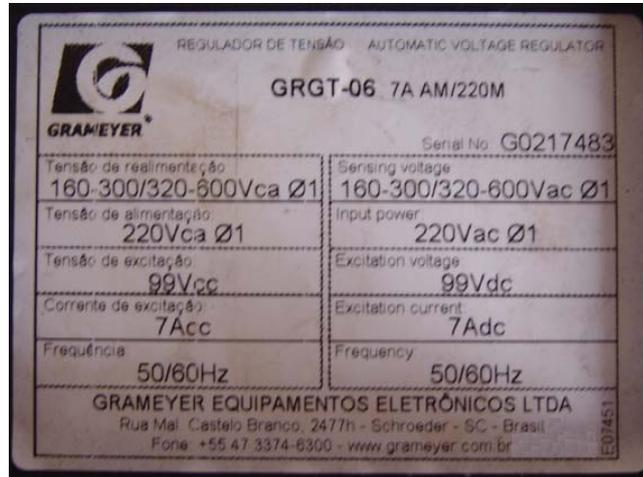
Figura 3.2. Fotografía de la chapa que muestra los datos nominales del AVR GRGT-06 7A AM/220M.
