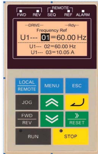
Figura. 2.6 - Vista del operador digital del VFD Yaskawa
