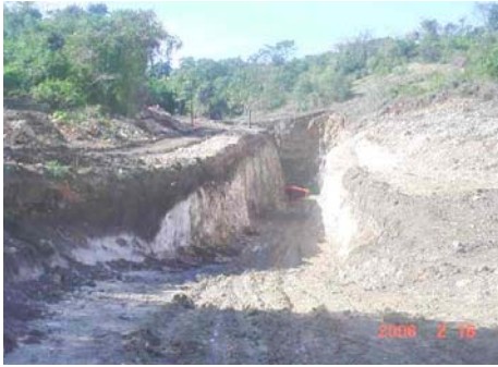
Fig.# 1 Trinchera de acceso al emboquille
