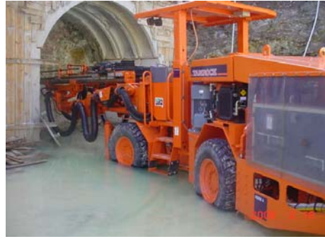
Fig #.2 Emboquille del túnel Ojo de agua yagrumal
