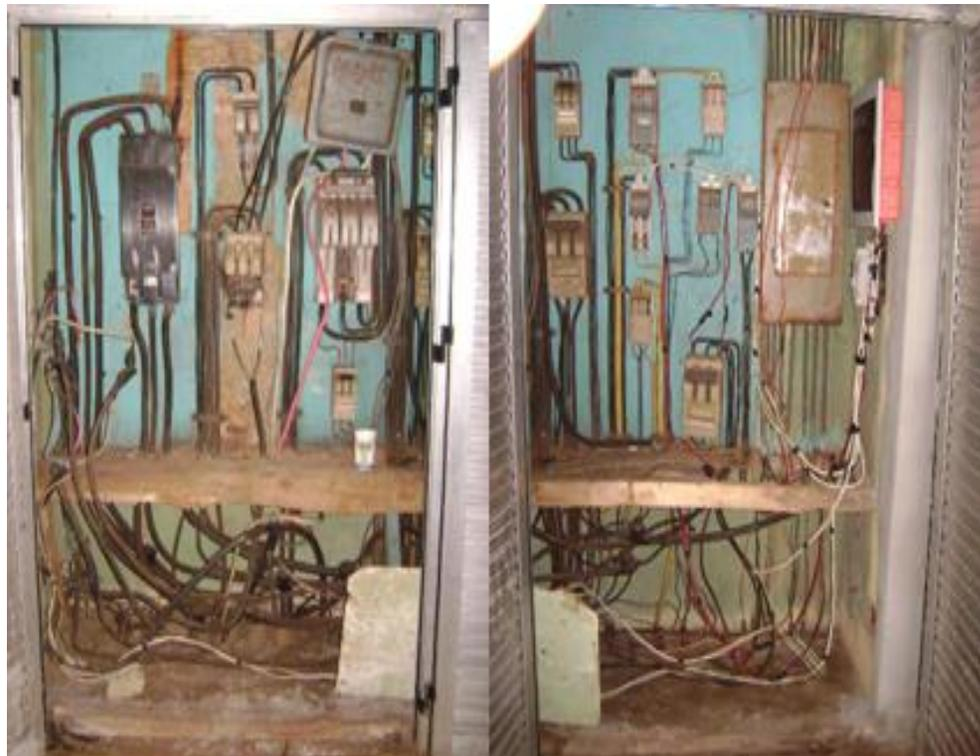
**Figura 2.4. Muestra del panel eléctrico del Docente 2. Estado crítico y peligroso.**
