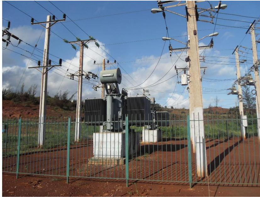
Figura 2.2 Transformadores de la subestación Moa Nueva.
