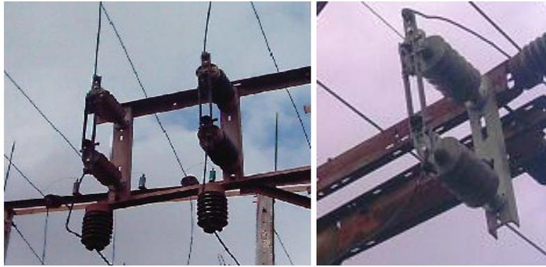
Figura 2.3 Cuchillas usadas en el lado de baja tensión de los transformadores de las subestaciones.
