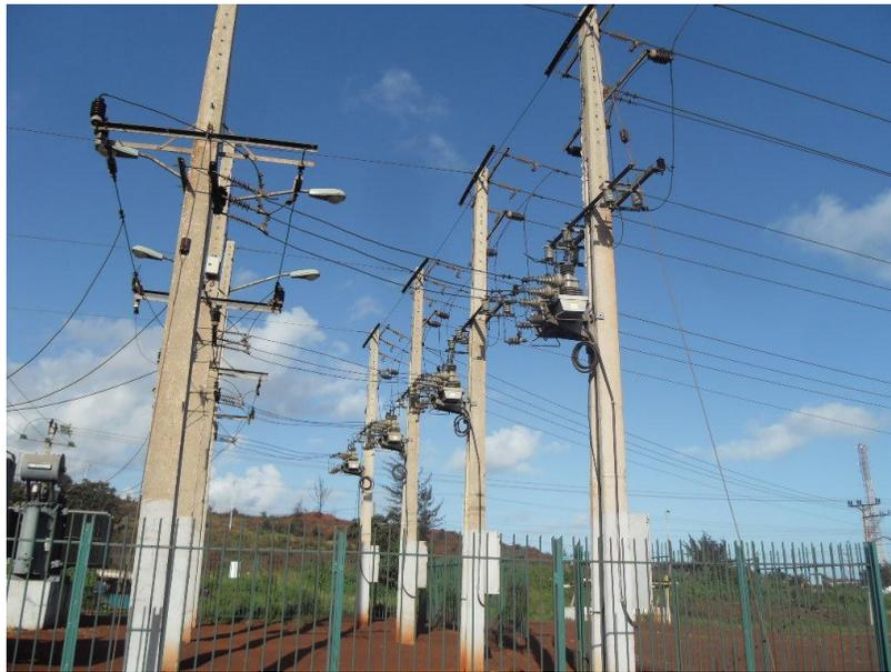
Figura 2.4 Recerradores Nulec usados en el inicio de las líneas de los circuitos 1, 4, 6 y 11.
