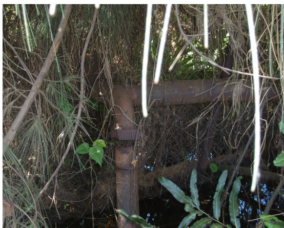
Tuberías y válvulas con alto estado de corrosión
