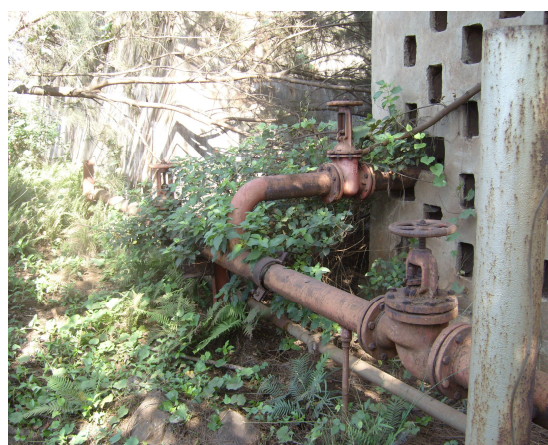
Tuberías y válvulas con alto estado de corrosión
