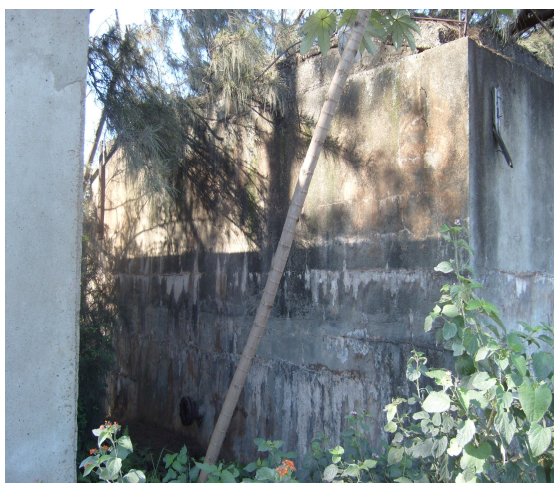
Tanque de reserva de agua contra incendios en mal estado físico
