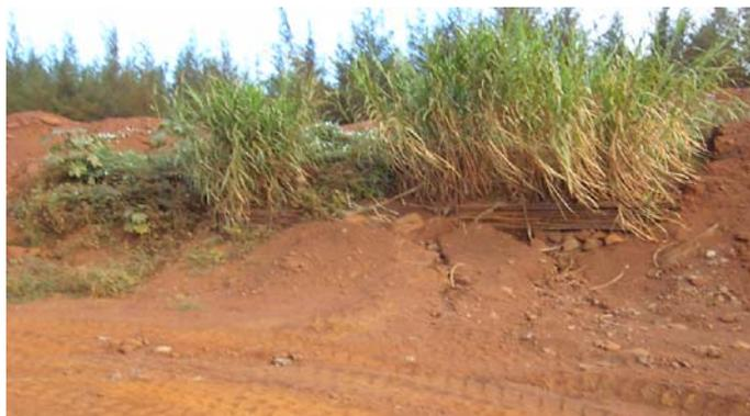
Foto 24. Control de la erosión de los suelos mediante madera, [Proyecto 1032, (2004)].
