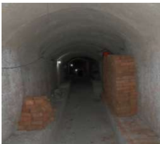
Figura. 2.1. Túnel revestido con muros de bloques de hormigón y bóveda de ladrillos de barro.
