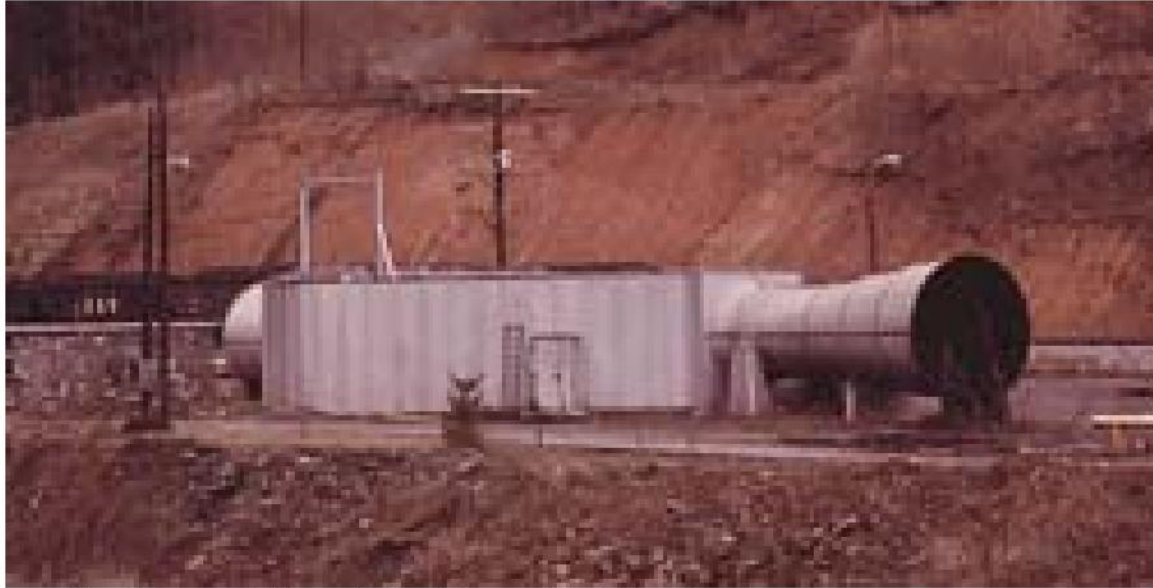
Ventiladores Minas de Carbón en Virginia, U.S.A.
