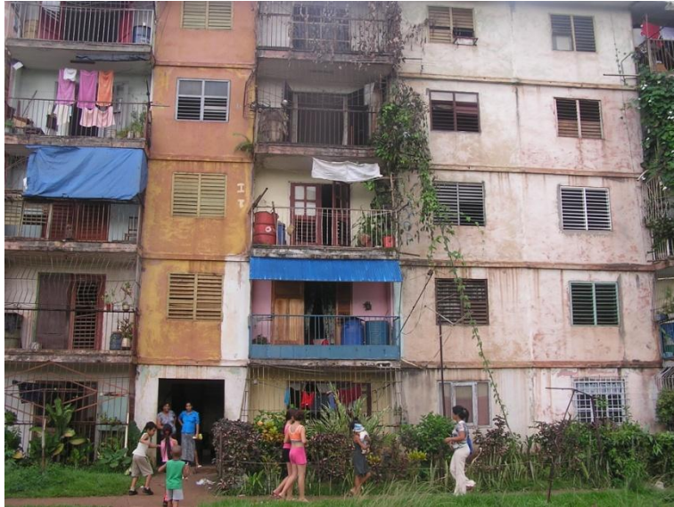
Fig. 3. Vista de niños áreas aledañas a los edificios.
