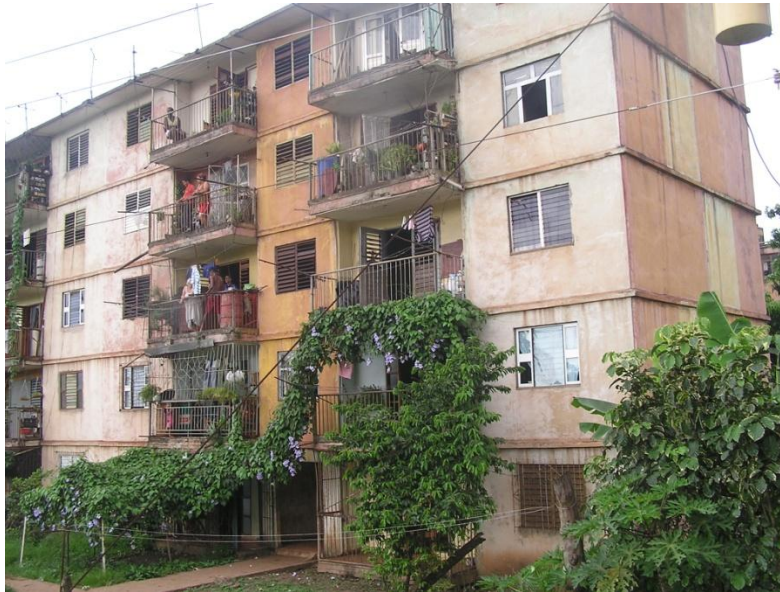
Fig. 1. Vista de uno de los edificios donde residen los entrevistados.
