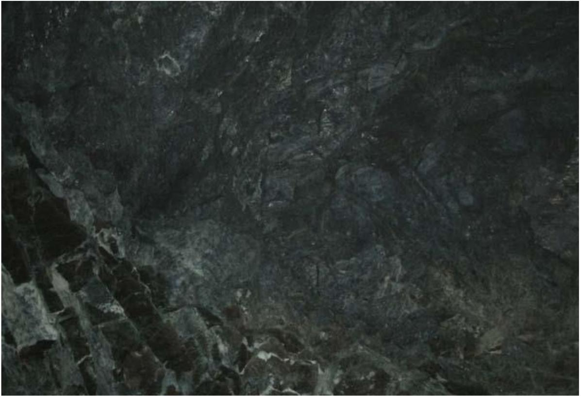
*Figura No 1.7 Foto No 2 Contacto visible durante la excavación del Tramo IV. Tipo II-III debajo y el Tipo IV-V arriba.*
