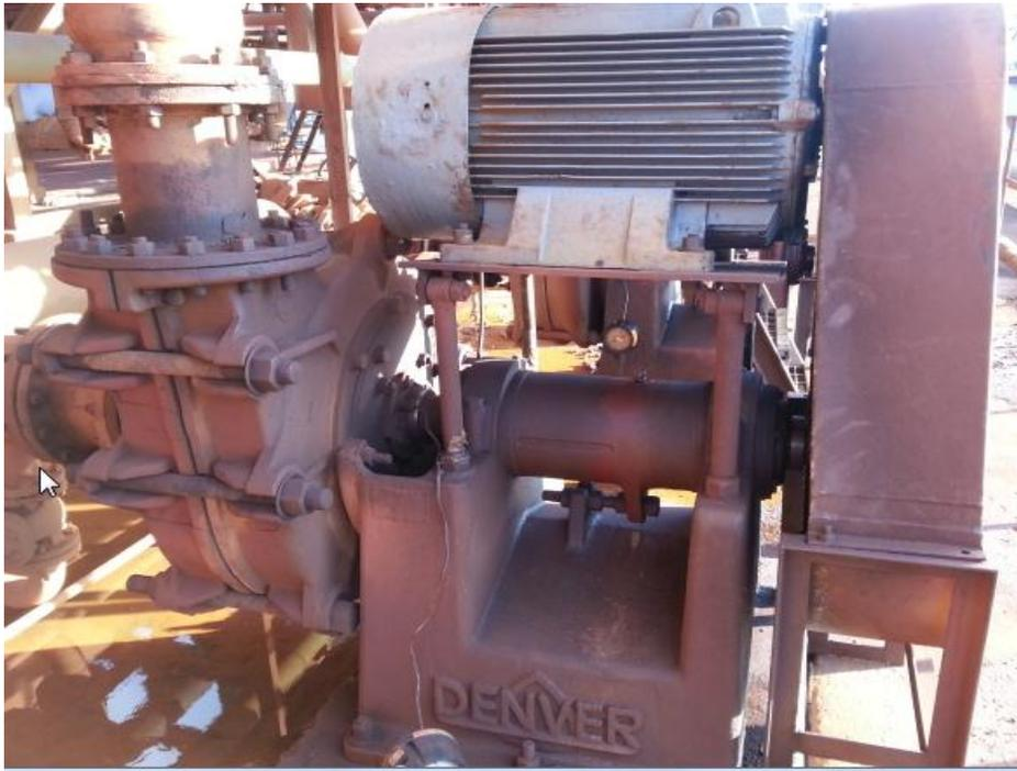
**Figura 1.4.** Bomba reforzadora 135-PU -23-A
