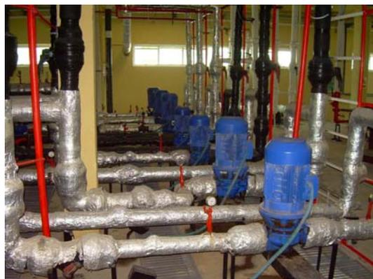
Figura 3.2 Distribución de las bombas del circuito secundario de agua fría.
