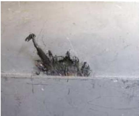
Figura 2. 12. Explosión interna en placas.
